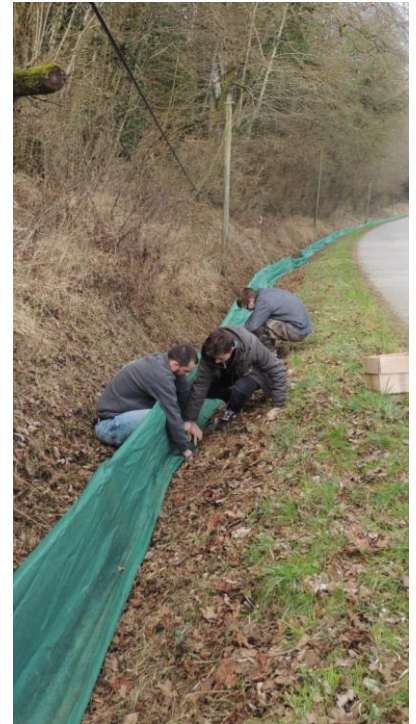
Installation de filet à Bazincourt
