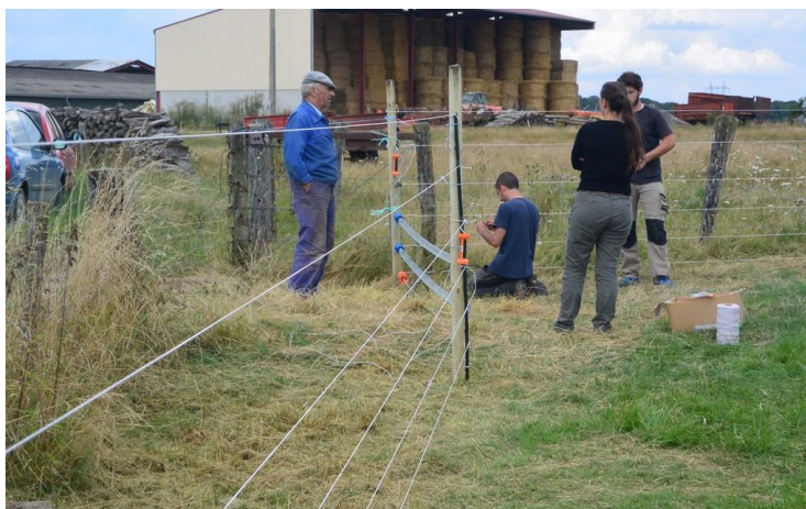
Chantier de pose de clôture à 6 fils avec LOANA et le GEML (Punerot, août 2016)
