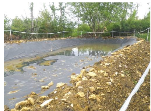
terrassement et bâche posée
